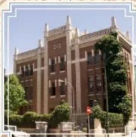
1923 NAVE DE MOTORES VALDERRIBAS 49
